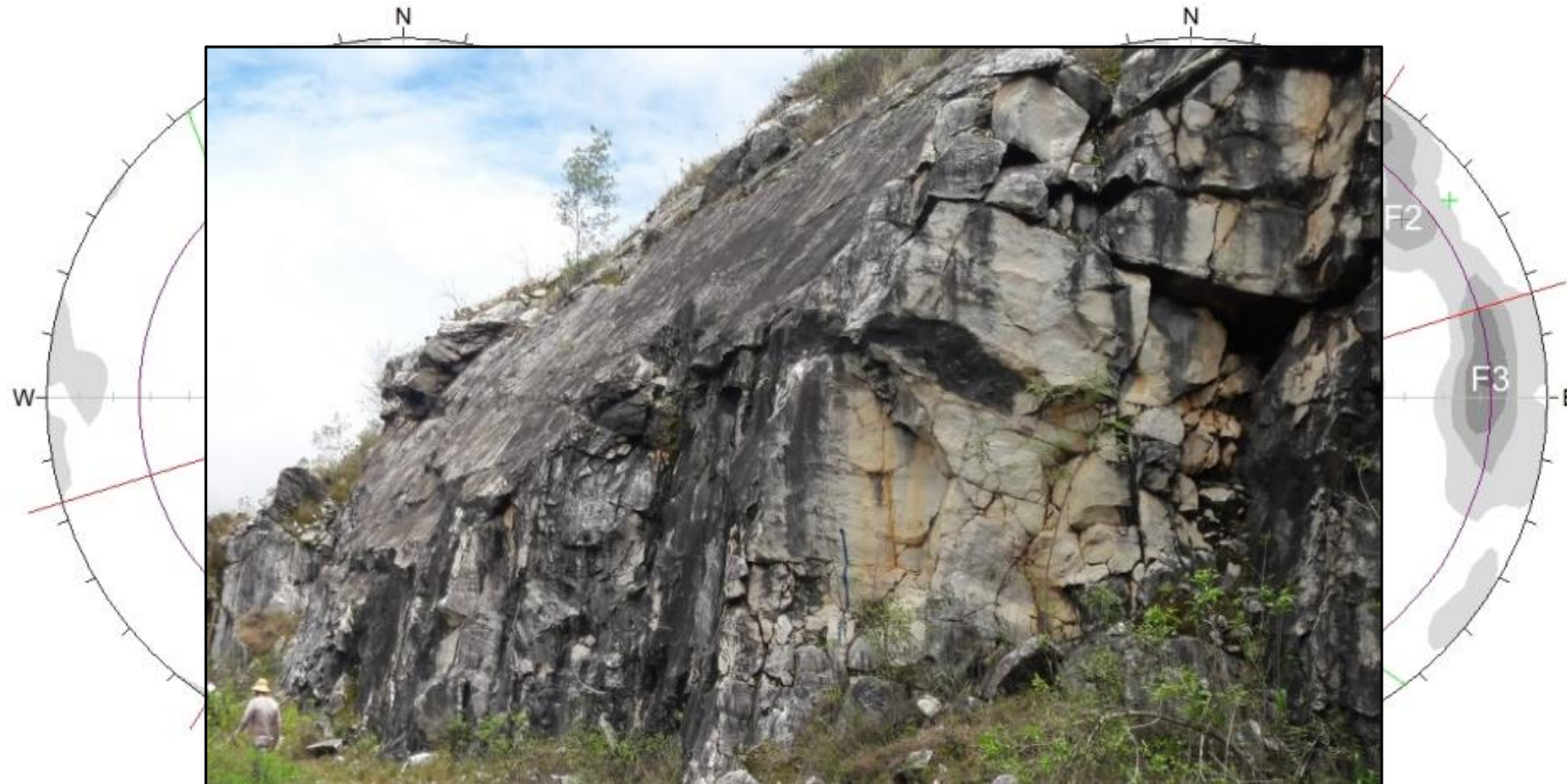
Figura 15. a) Grande ruptura planar afetando o talude NE1.
